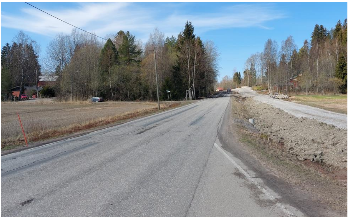
Kuva 3. Rantatien varteen on rakenteilla jkpp-väylä. Taustalla Martinraitin liittymä (Ramboll 5/2022)
