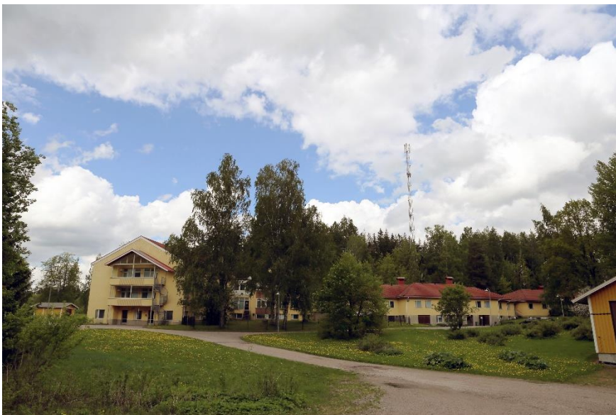
Kuva 3-23. Vanhainkoti ja sen eteläpuolinen pihalue. Kuva: Ramboll 2022.
