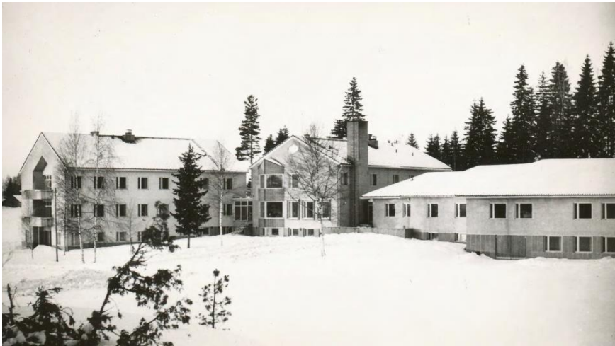
Kuva 3-25. Vanhainkoti vastavalmistuneena vuonna 1954. Kuvasta näkyy alkuperäinen A-talon parveke-muoto, A- ja B-talon välinen terassi sekä C-talon terassi umpikaiteineen. Ulkoportaat C-talon terassin etupuolelle lisättiin todennäköisesti myöhemmässä vaiheessa. Kuva: Pyhäniemen vanhainkodin rakennushistorian selvitys (Sitowise 2021) / Hollolan kunnan kuva-arkisto.
