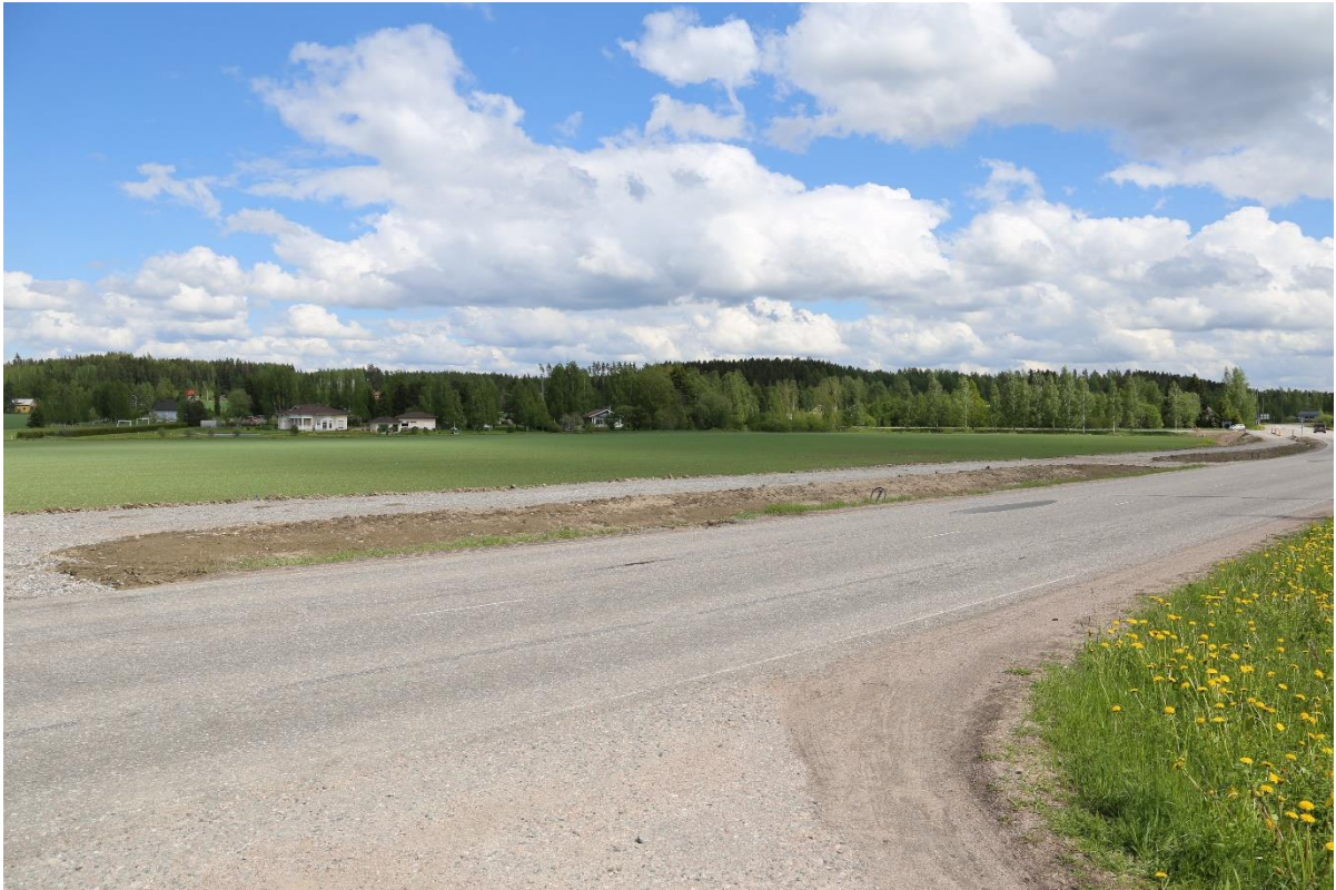
Kuva 3-26. Yhdystien 2956 eli Rantatien varteen on rakenteilla kevyen liikenteen väylä.
