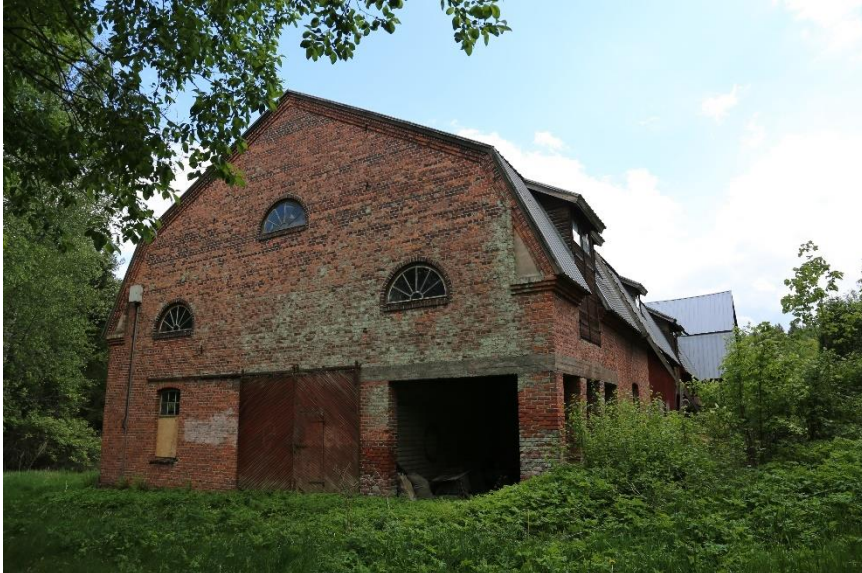
Kuva 3-17. Vanhan puimalarakennuksen pohjoispääty. Kuva: Ramboll 2022.
