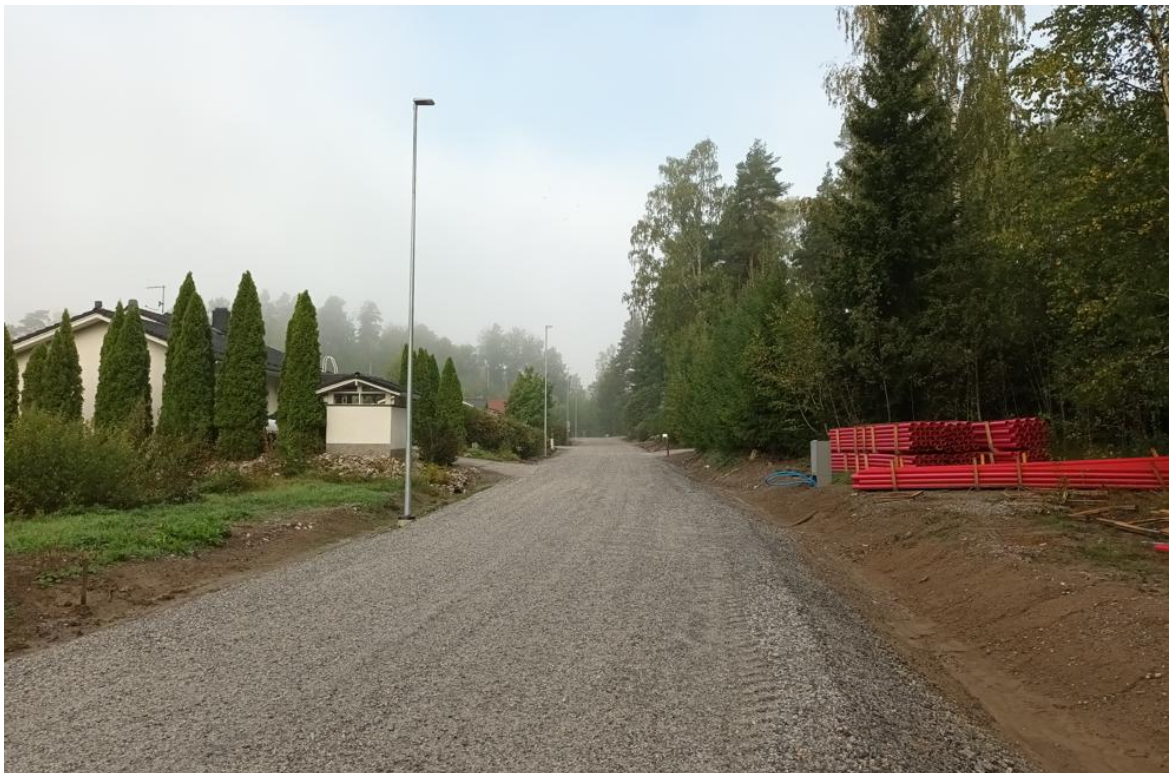
Kuva 5. Aiemmin saneerattua Norolantietä kohti länttä ja Toisenmäentietä katsottuna. [Ramboll 16.9.2024]
