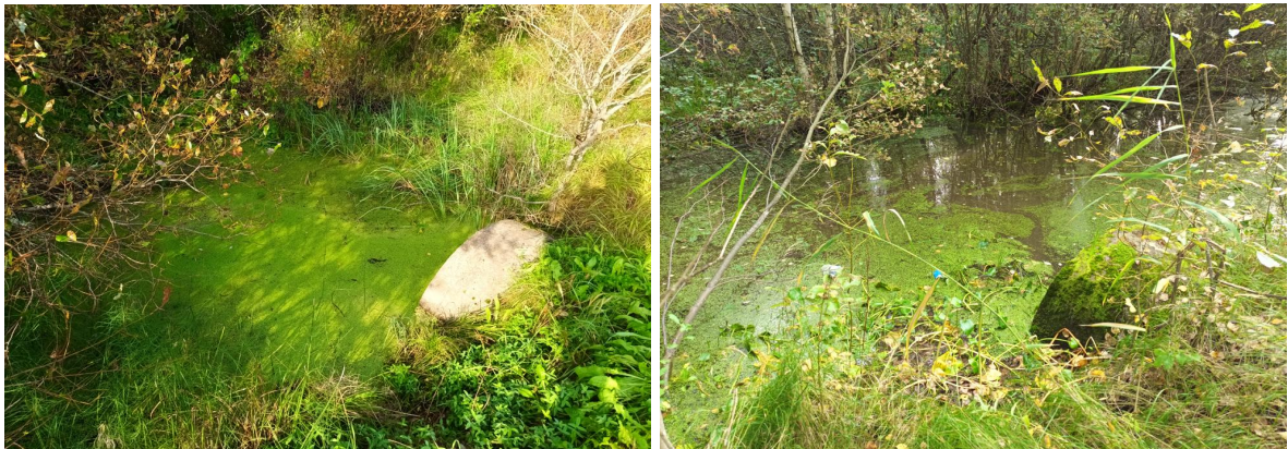
Kuva 13. ja 14. Karjusaarenkadun alittava 1200 mm betonirumpu, vasemmalla kuva rummun yläjuoksulta kadun pohjoispuolelta ja oikea kuva rummun alajuoksulta. [Ramboll 16.9.2024]
