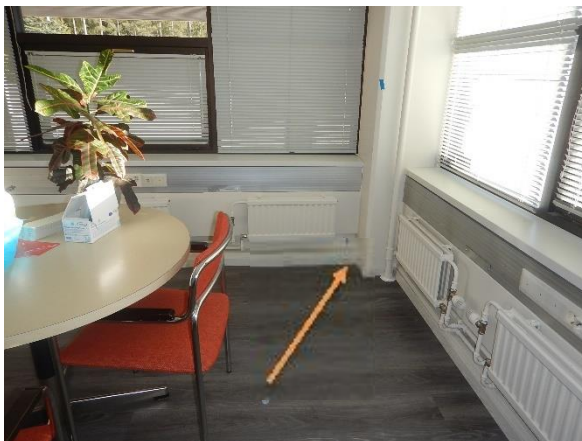
Kuva nro 15. Homekoira ilmaissut ulkonurkkaa
