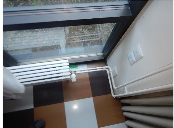
Kuva nro 8. Ruokalan lattiapinnotteessa mikrobivaurioita
