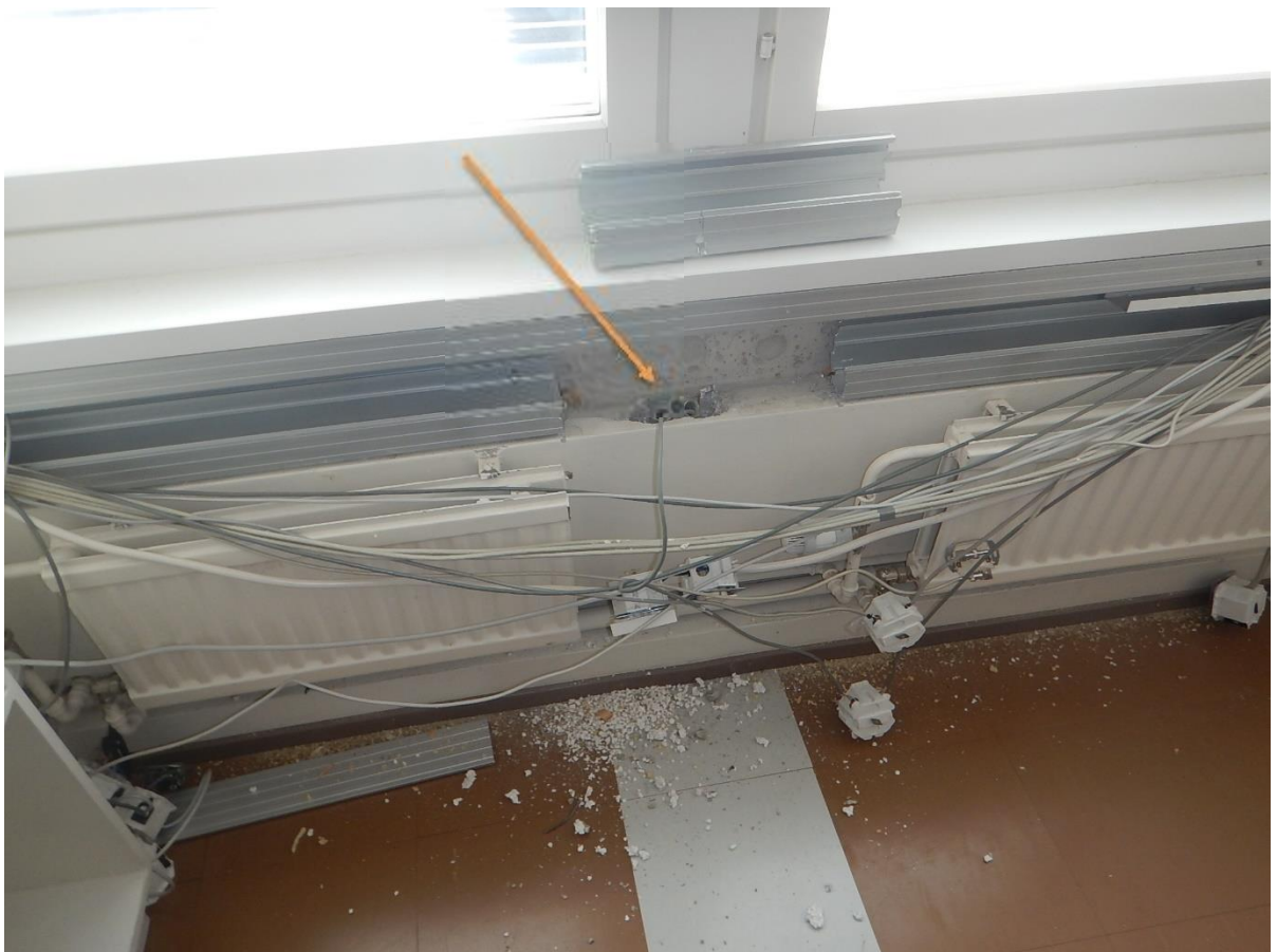
Kuva nro 4. Sähköjohtokourun takana on reiät ulkoseinäelementin sisään. Reikien kautta on ilmayhteys ulkoseinärakenteen ja sisätilojen välillä.
