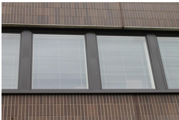
Virasto-osa A:n toimistohuoneiden ikkunoita.
