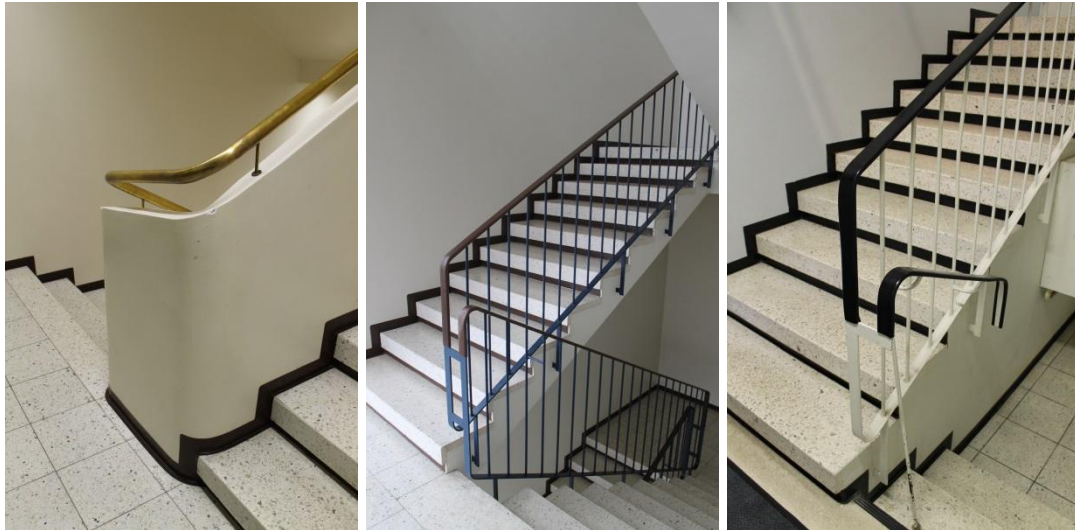
Pääporrashuone, B-porrashuone ja C-osan porrashuone.
