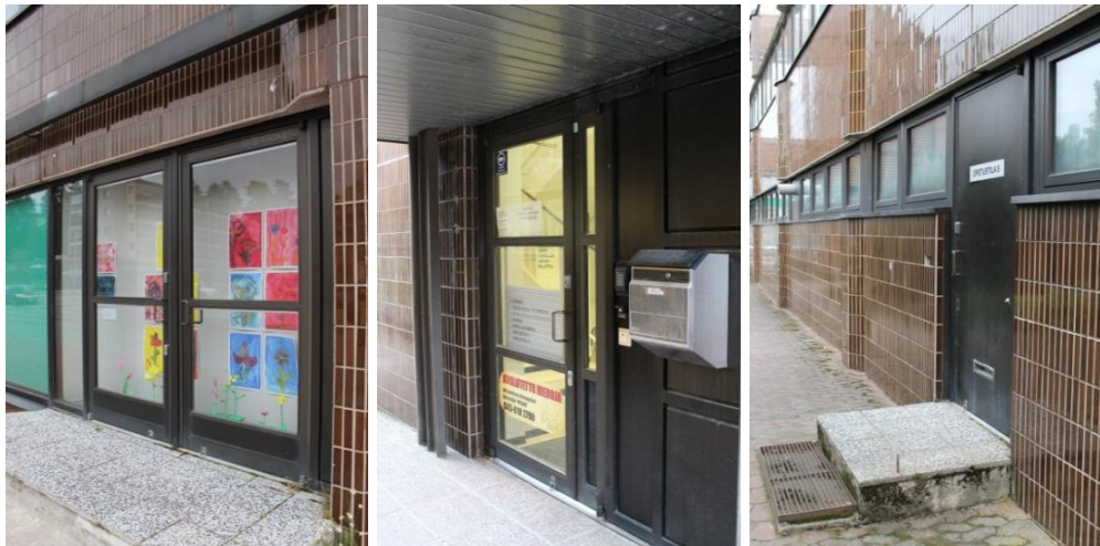
C-osan ulko-ovia. Vasemmalla Virastotien puoleinen sisäänkäynti, keskellä pääsisäänkäynti ja oikealla sisäpihan puoleinen sisäänkäynti.
