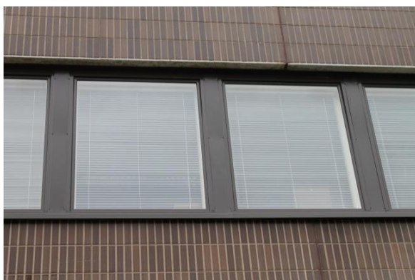
Virasto-osa A:n toimistohuoneiden ikkunoita.
