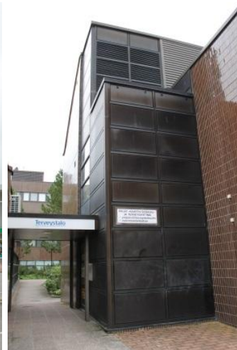
Liikesiipi C:n Virastotien puoleinen julkisivu. Päädyn hissi- ja varasto-osa rakennettiin 1990 ja verhoiltiin ruskealla anodisoidulla alumiinilla. Myös tasakattoinen sisäänkäyntikatokas on ruskeaa alumiinia.
