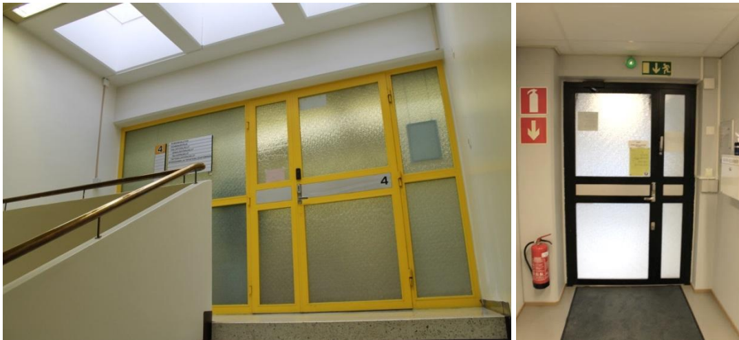
Porrashuoneiden yhteydessä on teräsrunkoiset palo-ovet. Vasemmalla pääporrashuoneen neljännen kerroksen palo-ovi ja oikealla C-osan porrashuoneen palo-ovi.
