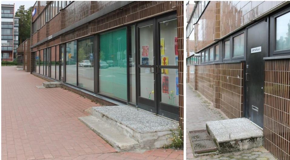
Liikesiipi C:n Virastotien puoleisella julkisivulla on kaksi kattamatonta sisäänkäyntiä ja sisäpihan puolella yksi kattamaton sisäänkäynti. Virastotien puoleiset ulko-ovet poikkeavat alkuperäisten piirustusten mukaisista.
