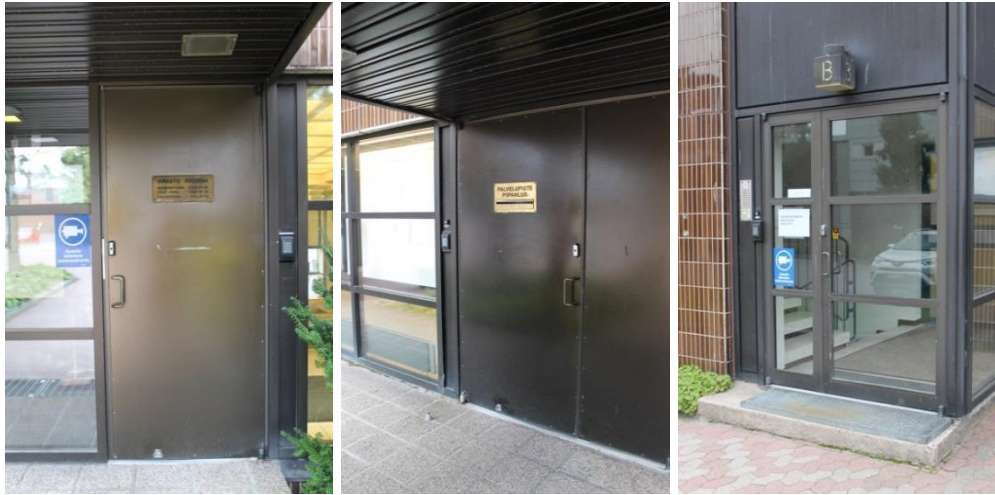
Virasto-osa A:n ulko-ovia. Vasemmalla pääsisäänkäynnin sisäpihan puoleinen ulko-ovi, oikealla pääsisäänkäynnin torin puoleinen ulko-ovi
