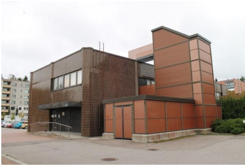
Liikesiipi C:n sisäpihan puoleinen julkisivu ja eteläpääty sekä vuonna 2003 rakennettu uusi porrashuone, varasto ja jätekatos. Laajennusosan julkisivumateriaaleina on käytetty kuparin väristä profiloitua peltiä ja reikäpeltiä.
