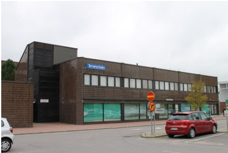
Liikesiipi C:n Virastotien puoleinen julkisivu. Päädyn hissi- ja varasto-osa rakennettiin 1990 ja verhoiltiin ruskealla anodisoidulla alumiinilla. Myös tasakattoinen sisäänkäyntikatokas on ruskeaa alumiinia.
