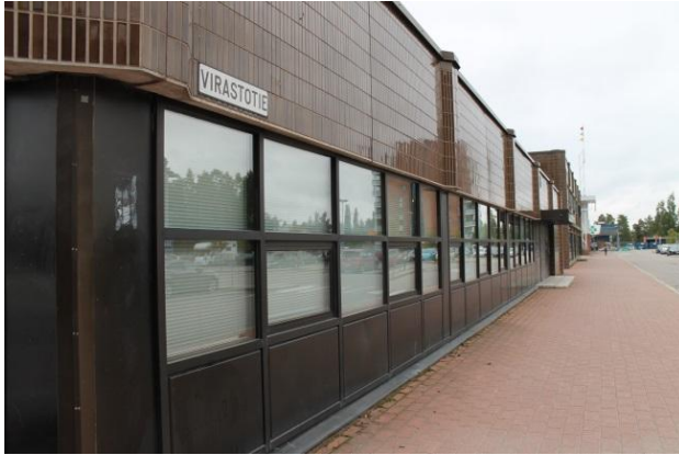
Julkisivulaatan, lasin ja alumiinin yhdistelmä Virastotien puoleisella julkisivulla.
