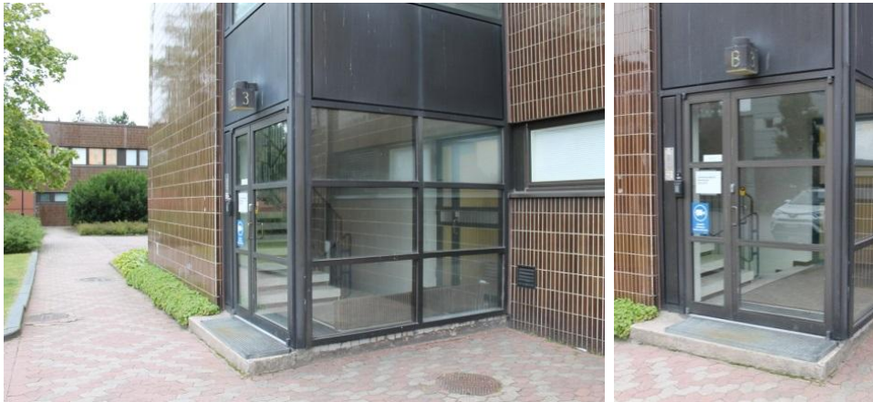
Virasto-osan A eteläisen porrashuoneen B sisäänkäynti ja ovi.
