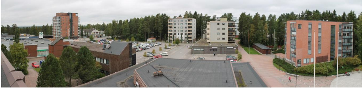
Näkymä virasto-osan A katolta länteen. Vasemmalla liikesiipi C.
