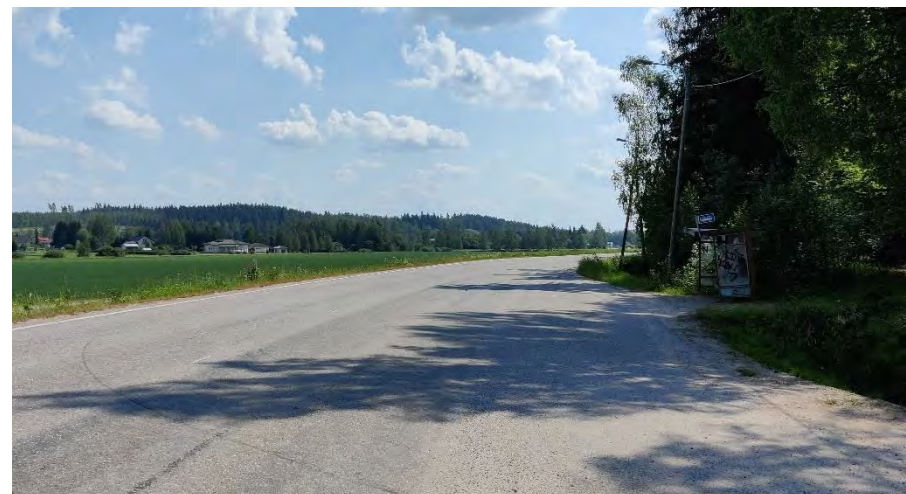
Kuva 41. Rantatien ja Ehtootien risteys. Oikealla julkisen liikenteen pysäkki.
