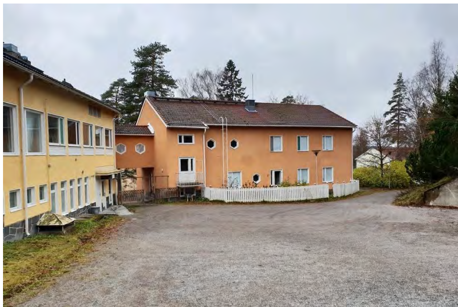
Kuva 22. 2020, Henkilökunnan asuintalo (D-talo), joka muutettiin hoitosiiveksi. Lähde: http://worldwar1airsoft.com/ (13.7.2021).
