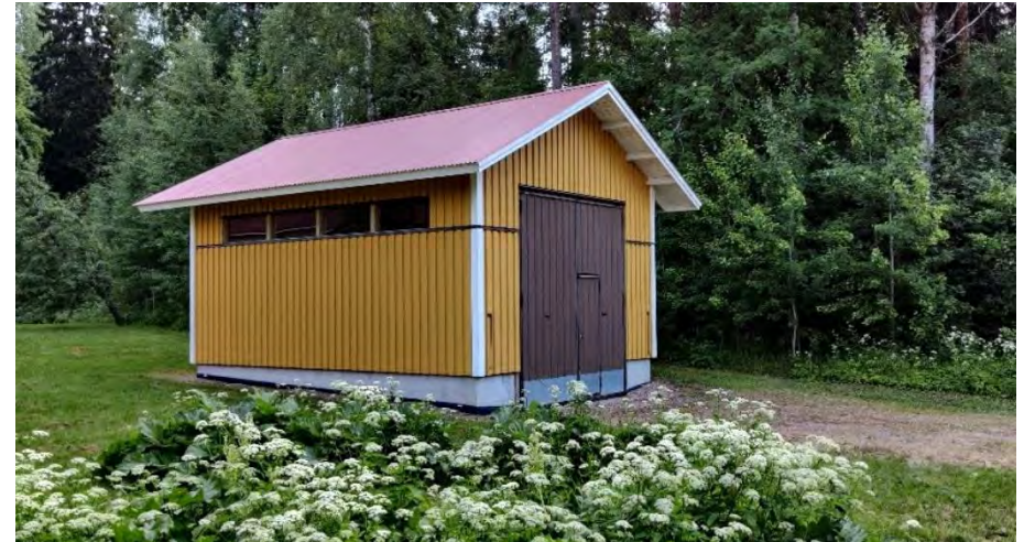
Kuva 48. Vanhainkodin entinen varavoimakeskus, joka nykyään käytetään varastona.
