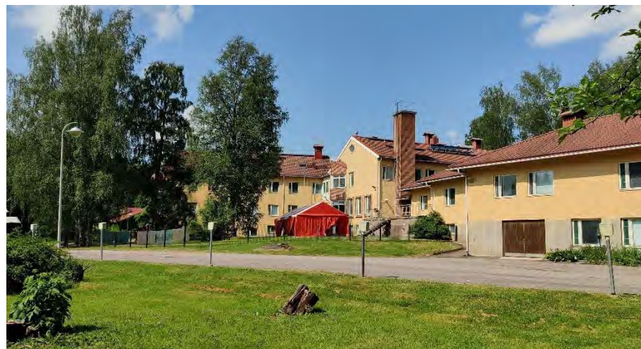
Kuva 52. Näkymä pihasta luoteeseen kohti A-, B- ja C-taloja. Talojen eteläpuolella on aidattu ulkoilupiha.
