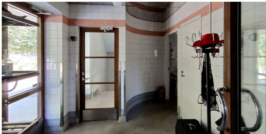
Kuva 111. Talo B, keittiön aula. Keittiö peruskorjattiin vuosina 1982 ja tietävästi 2010 (muutoskuvia vuodelta 2010 ei saatu).
