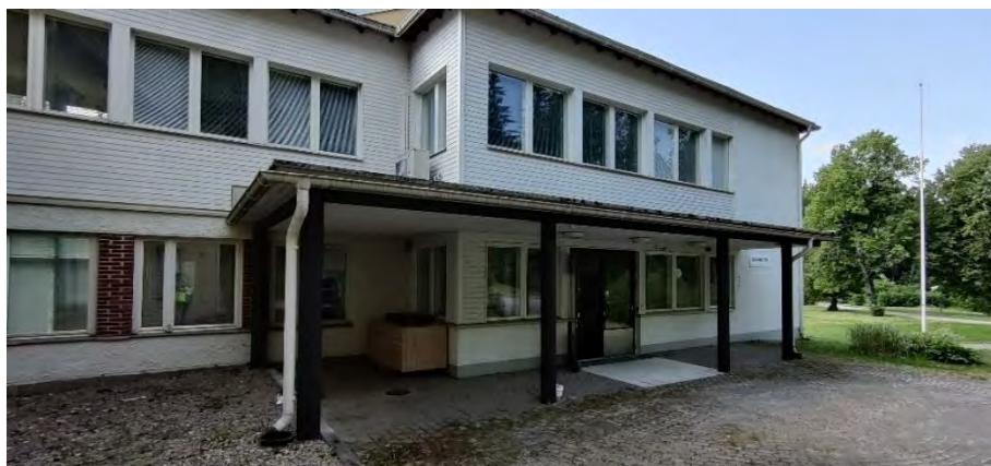
Kuva 53. Talo A, 2. kerroksen pohjoisterassin paikalle tehtiin oleskelutila vuonna 1973. Tila laajennettiin ja korjattiin vuonna 2010.
