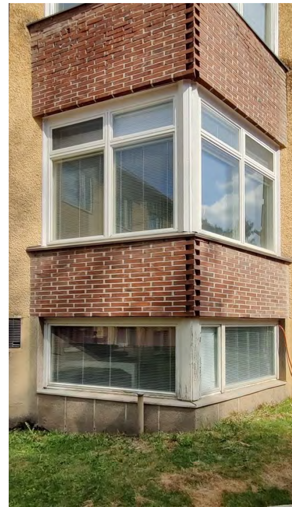
Kuva 69. (Keskellä) Talo B, erkkeri-ikkuna etelään ja alkuperäinen ulkoporras. Erkkeri-ikkunat on uusittu puualumiiniseksi ensimmäisessä ja toisessa kerroksessa, mutta julkisivun ilme on säilynyt. Kellari-ikkuna on alkuperäinen.
