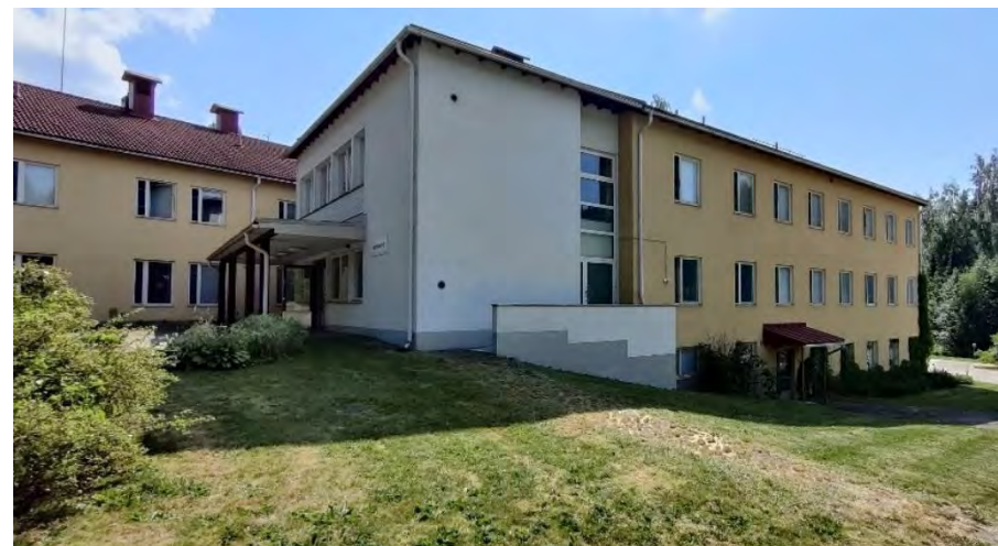
Kuva 60. Talo A, julkisivu länteen. Valkoiset ulkoseinät (sandwich-rakenteisia kantavia betonielementtejä) ja lasiseinä lisättiin 2010.
