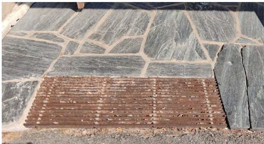
Kuva 65. Talo A, eteläpuolella oleva liuskekipipäällyste on todennäköisesti alkuperäinen.
