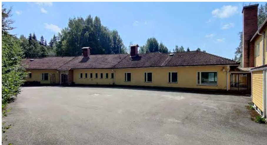
Kuva 79. Talo C, näkymä pohjoisesta.
