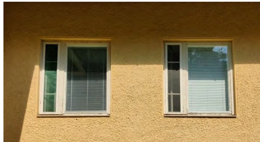
Kuva 85. Talo C, asuinhuoneiden ikkunat ovat alkuperäisiä puuikkunoita, matalampia B-talon ikkunoihin verrattuna.
