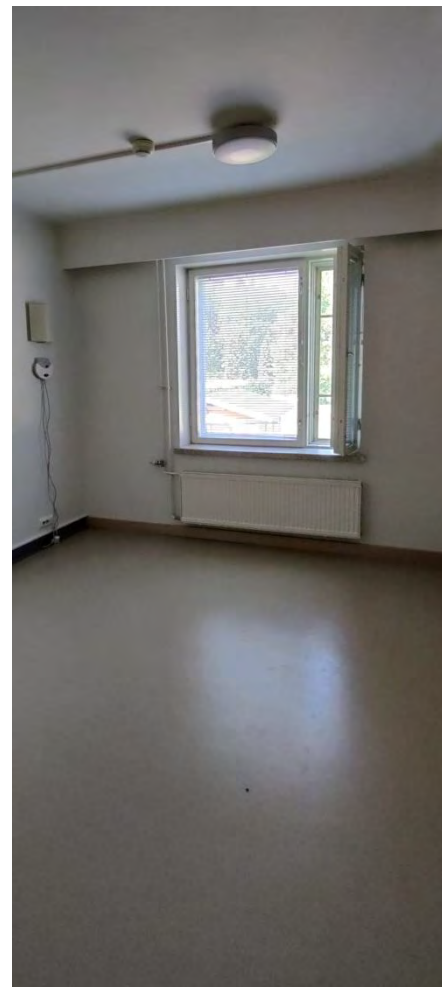
Kuva 109. (Vasemmalla) Asuinhuoneiden alkuperäiset puikkunat on kunnostettu.
