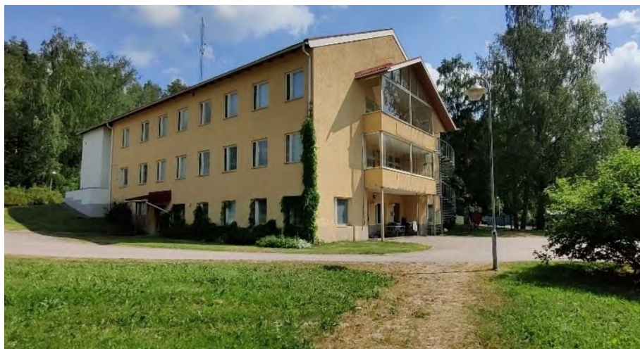
Kuva 58. Talo A, julkisivut etelään ja länteen. Parvekelasitus lisättiin vuonna 1998, kierreportaat ovat vuodelta 1982.
