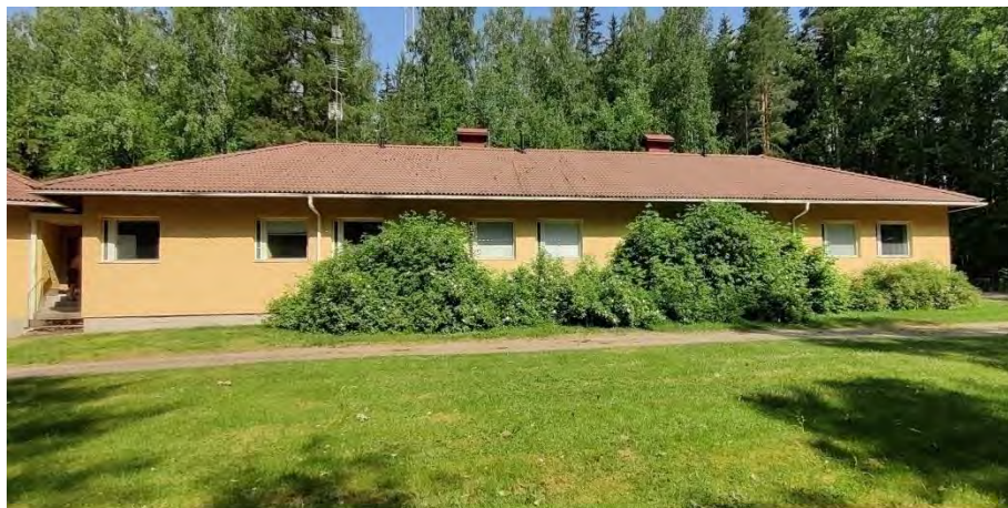
Kuva 95. Talo D, julkisivu etelään.
