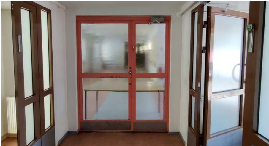
Kuva 120. Talo B, kulkuyhteys C-taloon. Oikealla ja vasemmalla tuulikaapit ja sisäänkäynnit etelään ja pohjoiseen.
