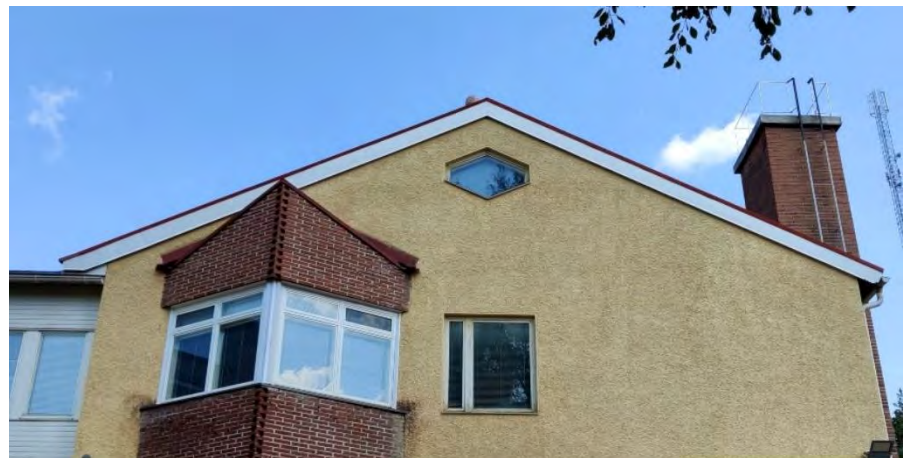
Kuva 73. Talo B, erkkeri-ikkunan yläpohja ja ullakon ikkuna.
