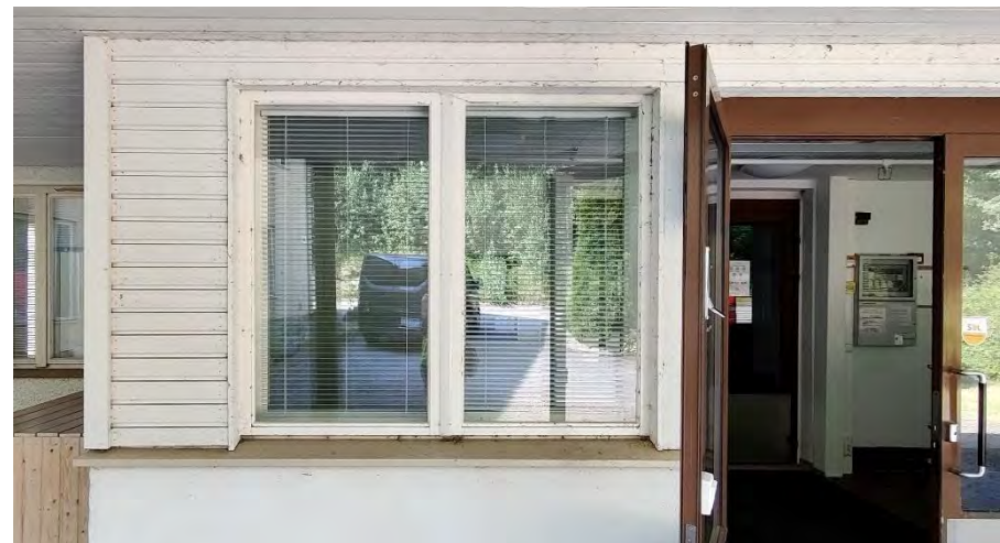
Kuva 55. Talo A, tuuli-kaappi, ikkunat ja ulko-ovi muutettiin ja peruskorjattiin vuonna 2010. Ikkunat ovat puualumiinisia.
