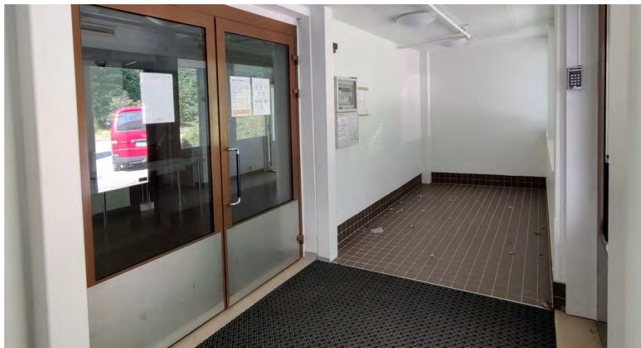
Kuva 99. Talo A, tuulikaappi muutettiin vuonna 2010.
