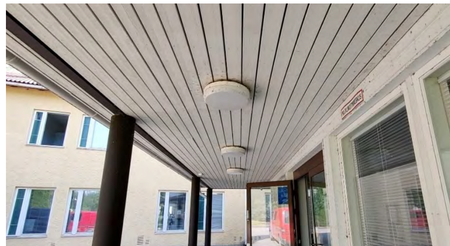
Kuva 56. Talo A, sisäänkäyntikatoksen puuverhous ja valaisimet ovat vuodelta 2010.
