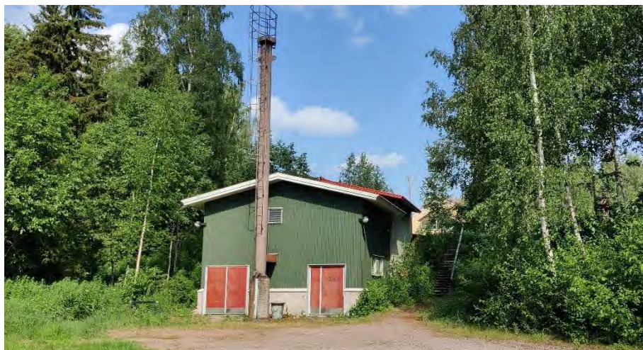
Kuva 39. Alueen lämpökeskus, julkisivu etelään.
