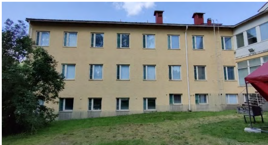
Kuva 57. Talo A, julkisivu itään. Julkisivun ilme on säilynyt. Kerrosten ikkunat ovat pääosin alkuperäisiä puuikkunoita
