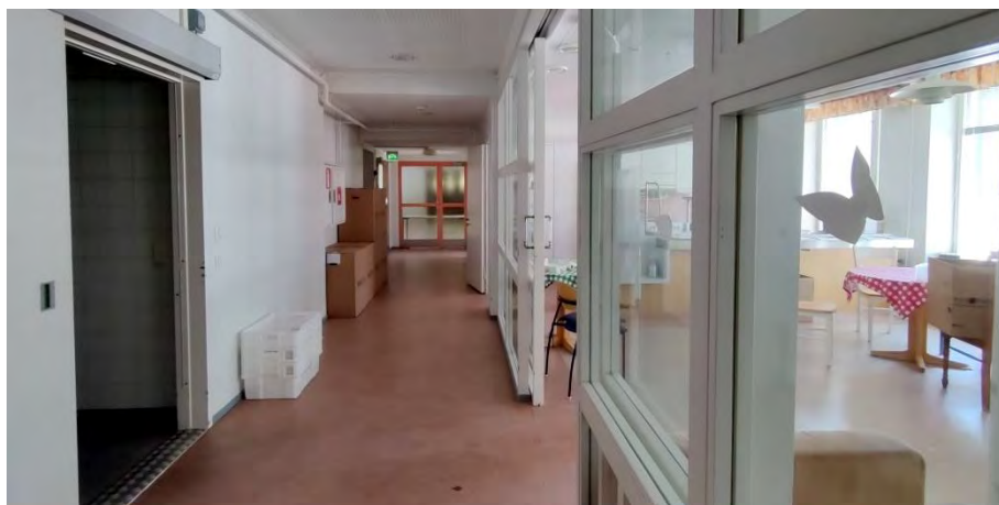
Kuva 116. Talo B, 1. kerroksen ruokailusali (oleskelutila). Lasiväliseinät on lisätty tietävästi vuoden 2010 peruskorjauksessa. B-talon 1. kerroksen muutospiirustus vuodelta 2010 ei ole saatu.
