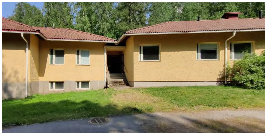
Kuva 96. Talojen C ja D välinen sisäänkäynti etelästä katsottuna. D-talon ikkunat ovat leveämpiä alkuperäisiä puuikkunoita. Sokkeliin on C-talon sokkelin korkeudella.
