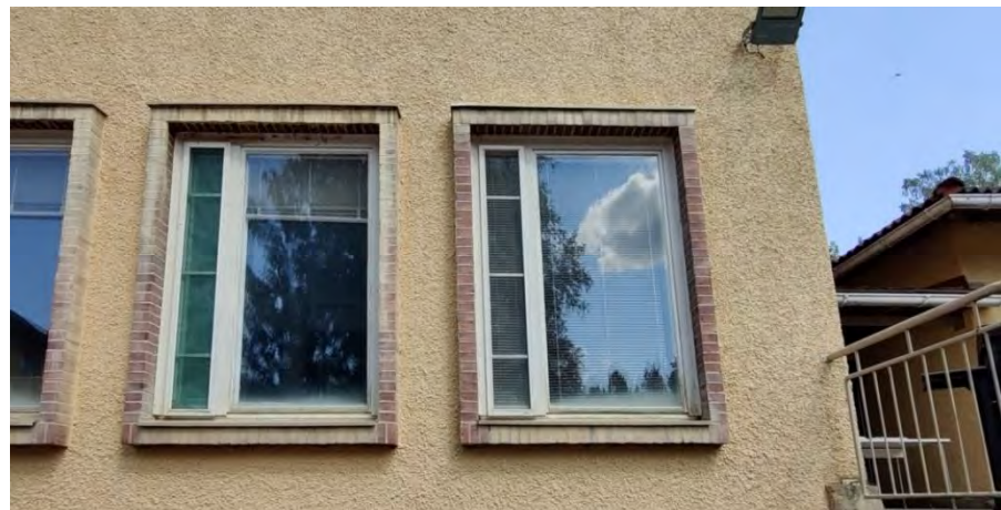
Kuva 74. Talo B, 1. kerroksen ikkunoilla on alkuperäinen punatiili-kehys. Ullakon ikkuna viittaa Vuorentaan vanhainkodin kuusikulmisiin pienikkunoihin.
