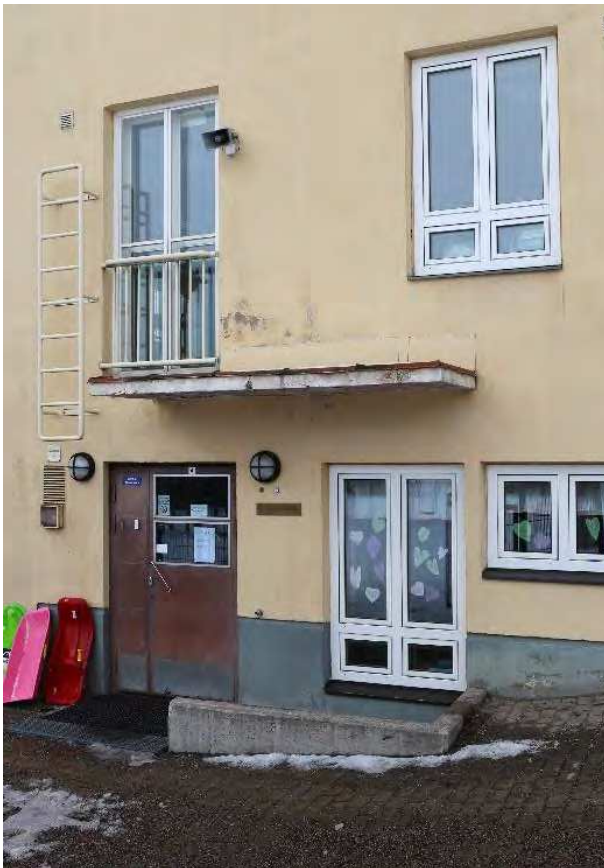
Kuva 69. Eteläseinustan sisäänkäynneistä toinen on muutettu ikkunaksi.
