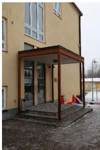
Kuva 38. Pohjoisen sisäänkäynnin yhteyteen rakennettiin katos.
