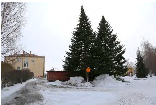
Kuva 60. Varastorakennuksen pohjoispuolella kasvaa kaksi komeaa pihakuusta.
