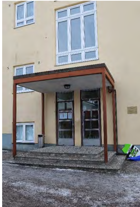
Kuva 70. Pohjoisseinustan sisäänkäynnin yhteyteen on myöhemmin rakennettu katos.
