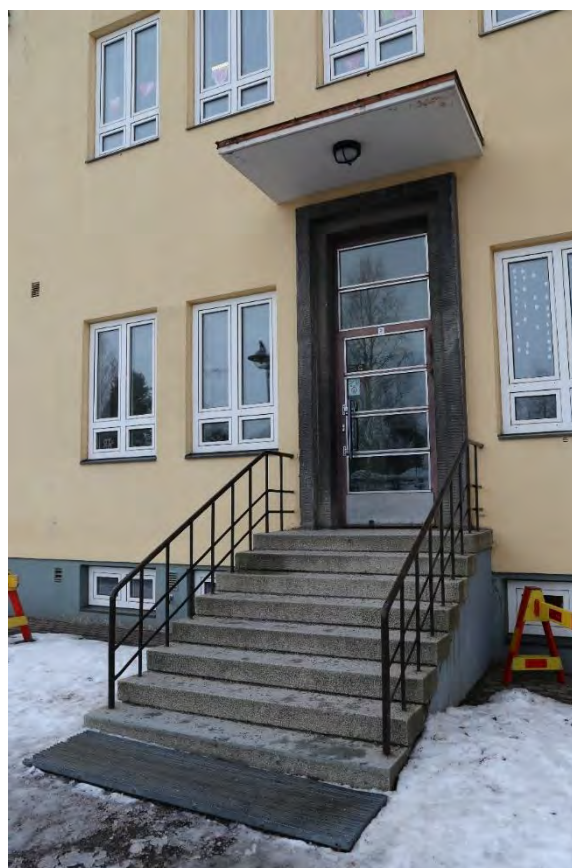
Kuva 68. Koulun pääsisäänkäynti on muita sisäänkäyntejä korkeampi.
