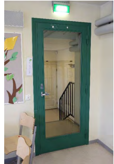
Kuva 77. Toisen kerroksen eteishallin ja eteläosan porrashuoneen välinen palo-ovi.
