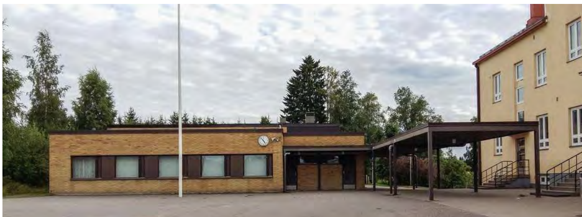
Kuva 28. Tiilikoulu purettiin 2018. (Etelä-Suomen sanomat. 25.10.2017. Kuvaaja Leila Mehto)
