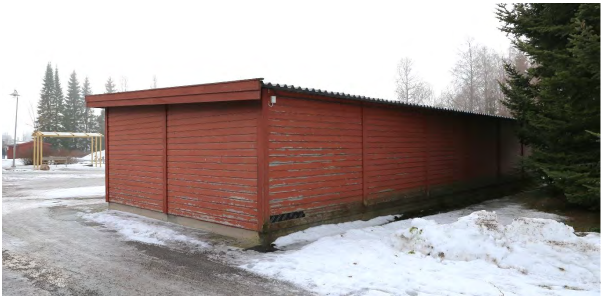
Kuva 130. Rakennuksessa ei ole ikkunoita.
