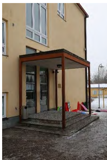
Kuva 38. Pohjoisen sisäänkäynnin yhteyteen rakennettiin katos.
