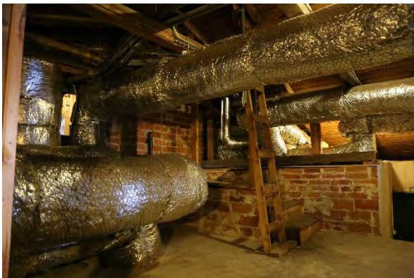
Kuva 111. Koulun rakennusmateriaalina on punainen tiili, joka on selvästi nähtävissä ullakolla.
