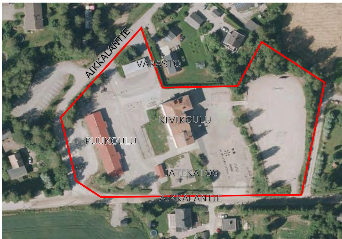
Kuva 56. Koulupiha jakautuu kivikoulun länsi- ja itäpuoleisiin pihoihin. Ortoilmakuva vuodelta 2021. (Ortoilmakuva: Hollolan kunta)
