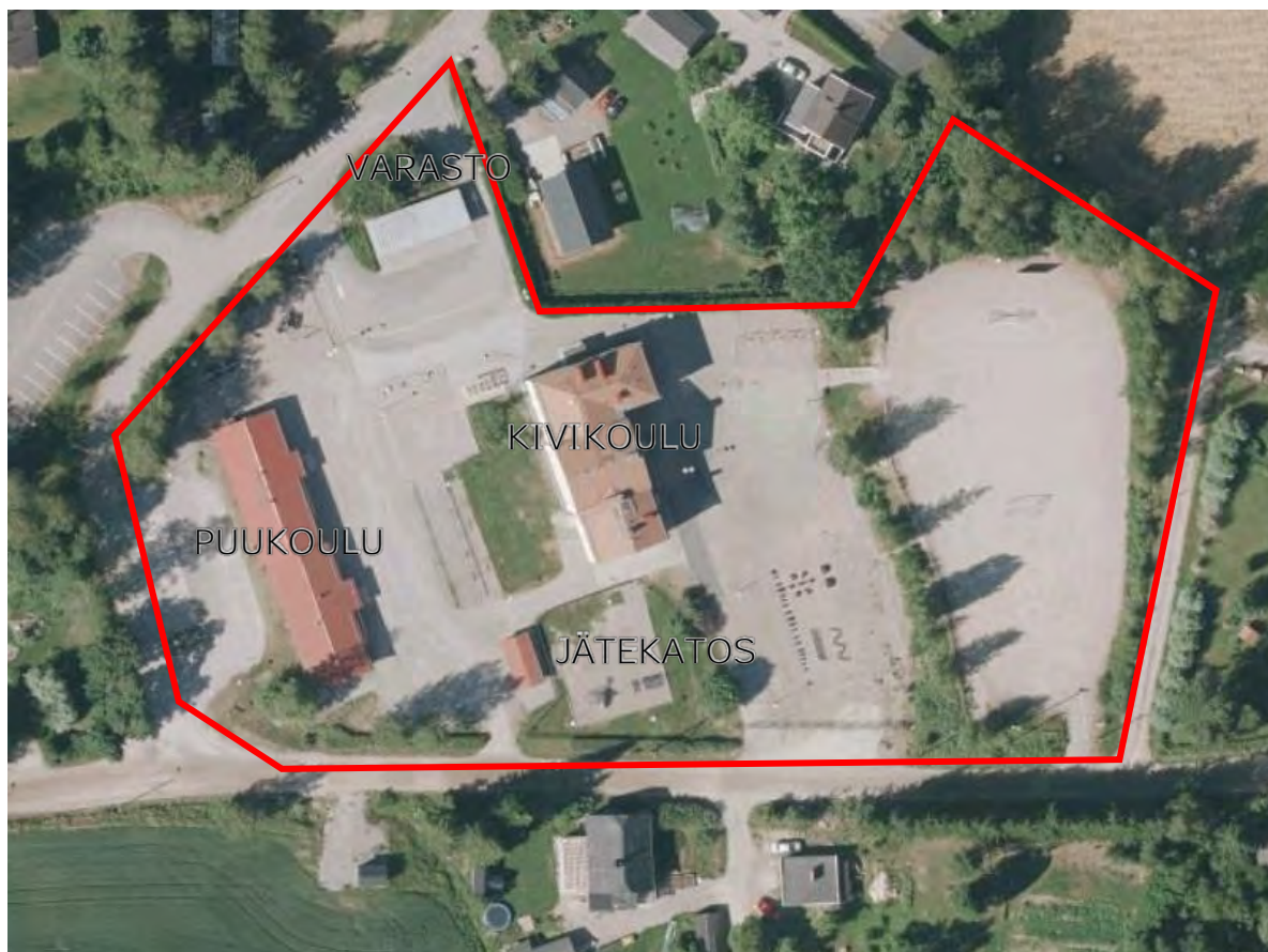
Kuva 2. Koulukiinteistölle sijoittuvat kivikoulu, puukoulu, jätekatos sekä varasto. Ortoilmakuva vuodelta 2021. (Ortoilmakuva: Hollolan kunta)
