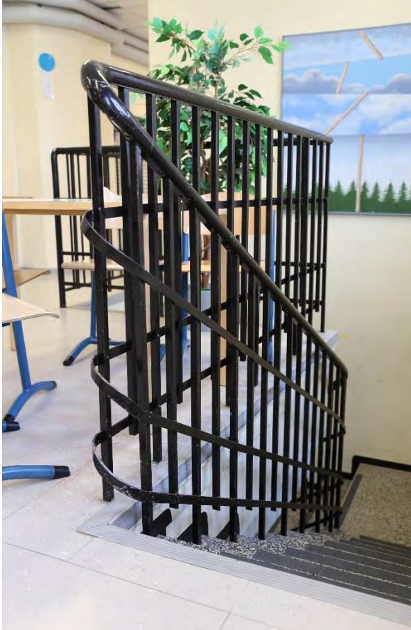
Kuva 84. Portaissa on alkuperäiset teräsrakenteiset kaiteet sekä mosaiikkibetoniportaat. Kuva toisen kerroksen aulatilän portaista.
