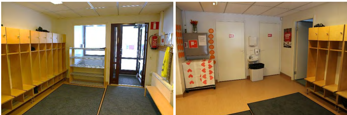
Kuva 122. Vanhan osan pääaula.
