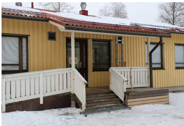
Kuva 115. Vanhan osan sisäänkäynti.
