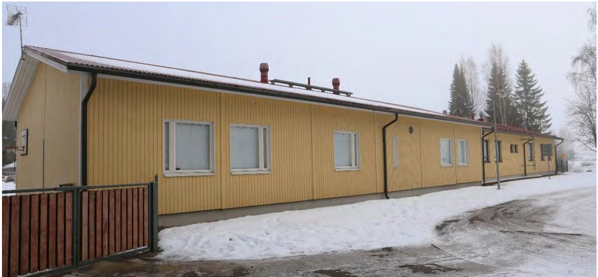
Kuva 114. Takajulkisivulle ei sijoitu sisäänkäyntejä.
