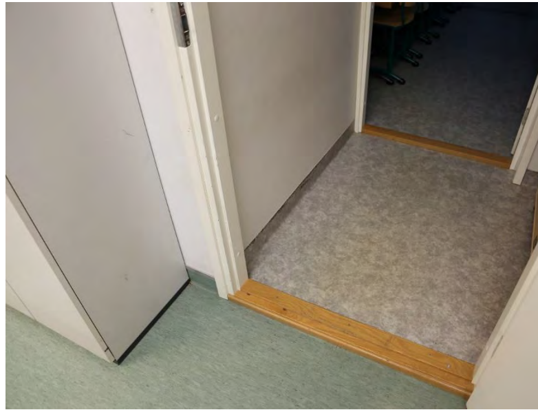
Kuva 126. Vanhan osan ja uuden osan välillä on pieni yhdyskäytävä. Kuvassa etualalla vanhaa osaa.
