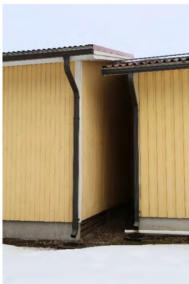
Kuva 119. Uuden ja vanhan osan liittymäkohta.
