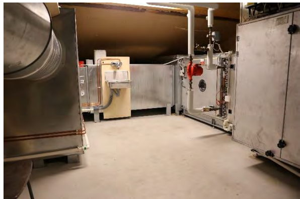
Kuva 112. IV-konehuone rakennettiin vuonna 2001.
