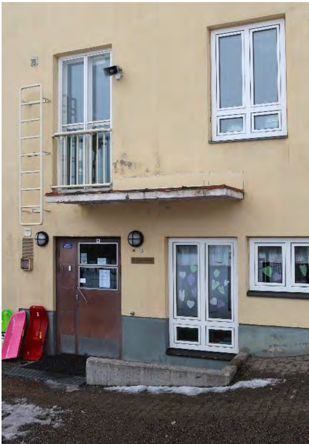
Kuva 69. Eteläseinustan sisäänkäynneistä toinen on muutettu ikkunaksi.
