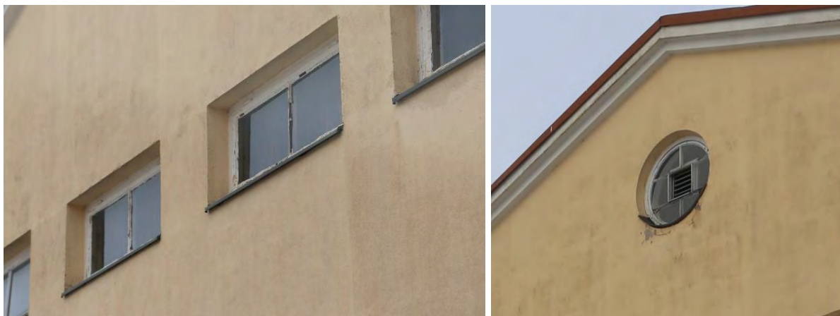
Kuva 66. Ullakkokerroksessa on säilynyt alkuperäiset ikkunat.
