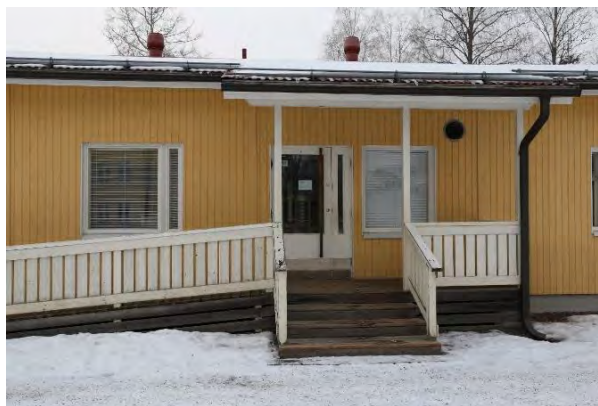
Kuva 116. Uuden osan sisäänkäynti.
