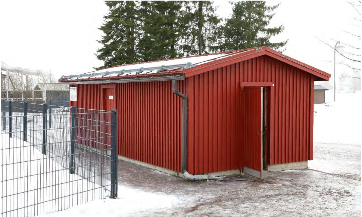
Kuva 131. Jätekatoksen pohjoisosassa on pieni varasto.
