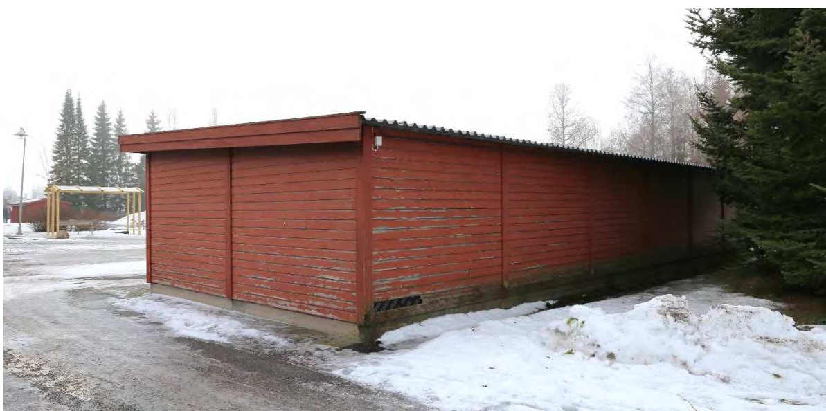
Kuva 130. Rakennuksessa ei ole ikkunoita.
