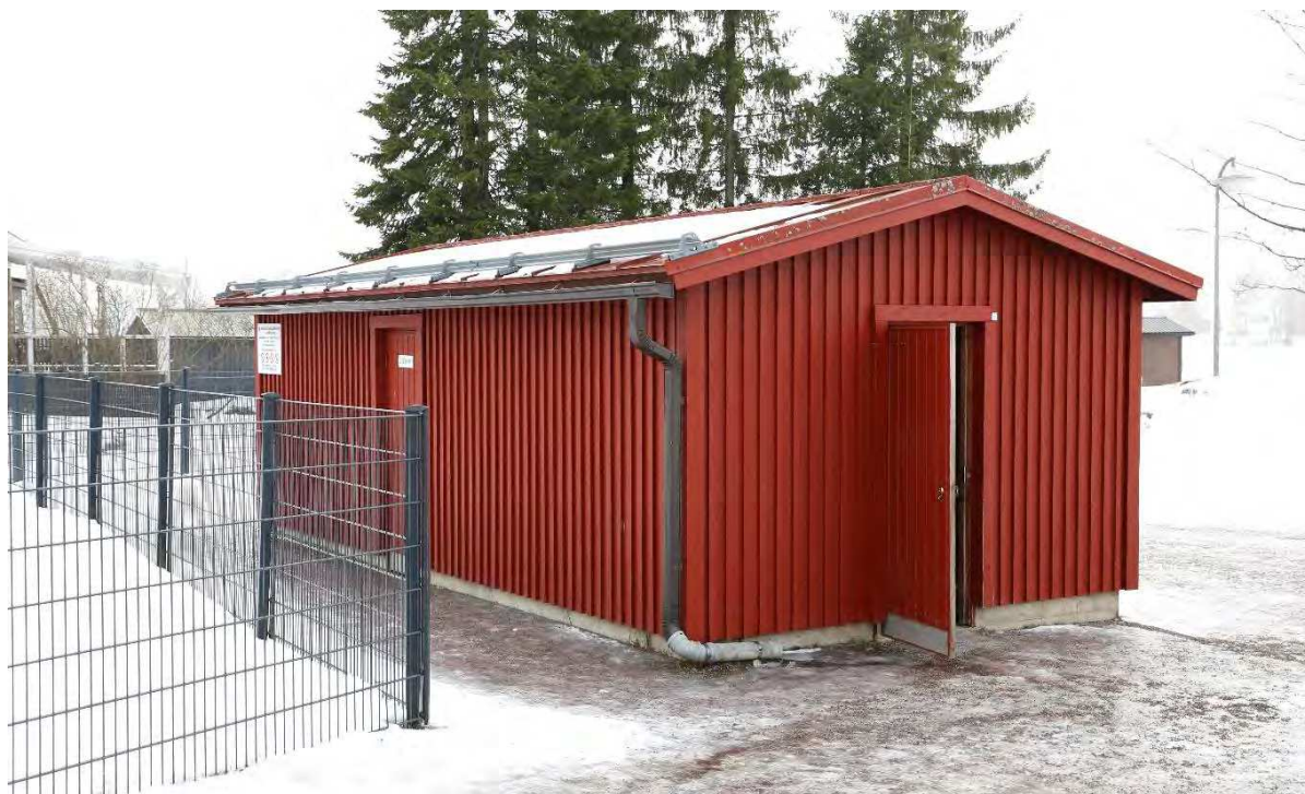
Kuva 131. Jätekatoksen pohjoisosassa on pieni varasto.
