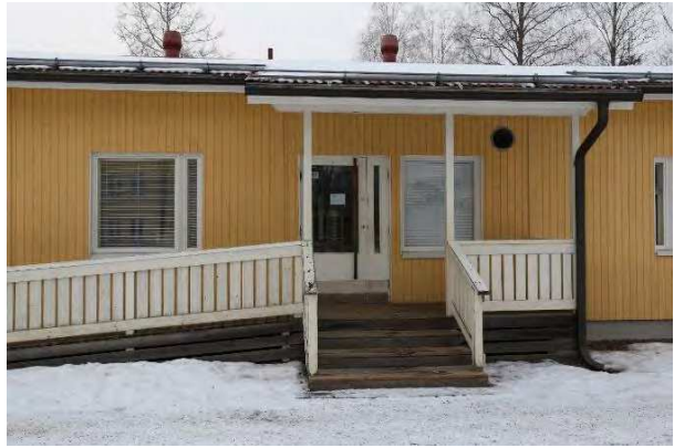
Kuva 116. Uuden osan sisäänkäynti.
