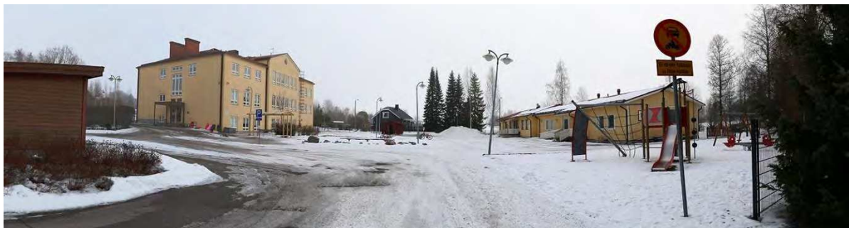
Kuva 57. Koulun länsipuoleinen piha-alue pohjoisesta kuvattuna.
