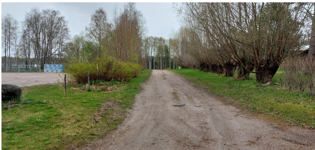
Kuva 7. Päiväsalontien alkupää etelästä kohti pohjoista katsottuna. [Ramboll 14.5.2025]
