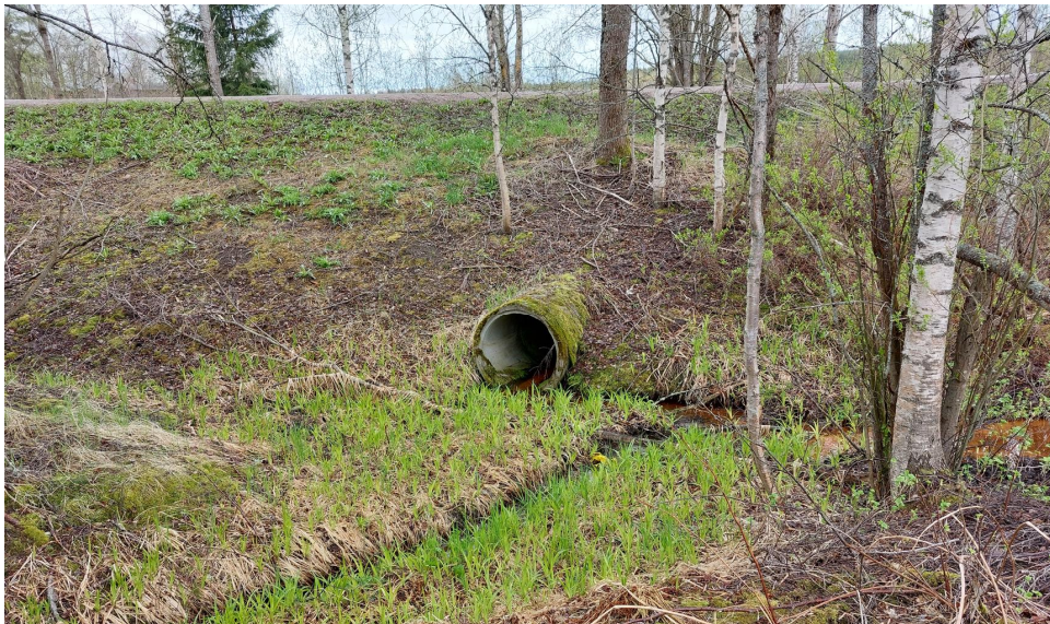
Kuva 12. Jarvalantien alittava nykyinen 800 mm betonirumpu. [Ramboll 14.5.2025]
