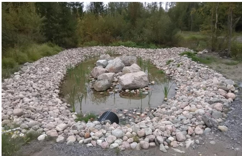
Kuva 18. Esimerkki hulevesipainanteesta hulevesiviemärin purkupisteessä ennen laskuojaa [Ramboll 2021]
