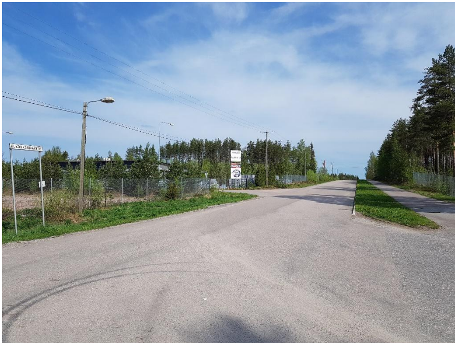
Kuva 7. Kukonkankaantie etelän suunnasta. [Ramboll 17.5.2021]
