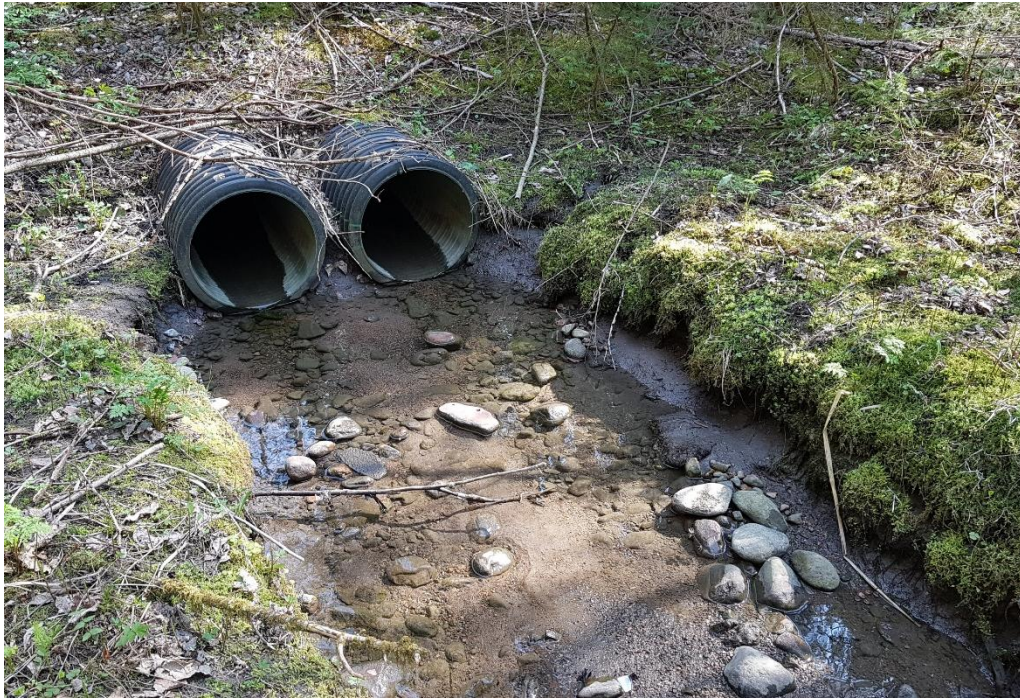
Kuva 25. Hulevesien purkupiste Valtatien 12 eteläpuolelle Monteron alueella [Ramboll 17.5.2021]
