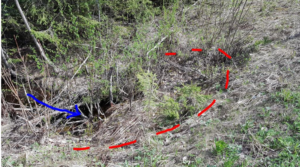
Kuva 27. Tenniläntien rummun yläjuoksun puoli [Ramboll 17.5.2021]
