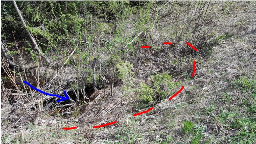
Kuva 28. Tenniläntien rummun yläjuoksun puoli [Ramboll 17.5.2021]
