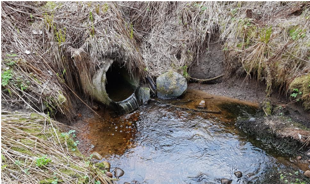
Kuva 29. Tenniläntien rummun alajuoksun puoleinen pää [Ramboll 17.5.2021]
