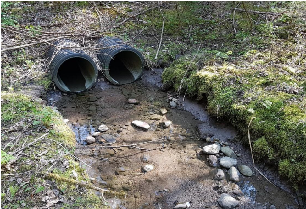
Kuva 26. Hulevesien purkupiste Valtatien 12 eteläpuolelle Monteron alueella [Ramboll 17.5.2021]
