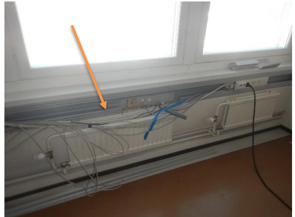
Kuva nro 3. Seinässä kulkee jokaisessa huoneessa sähköjohtokouru.
