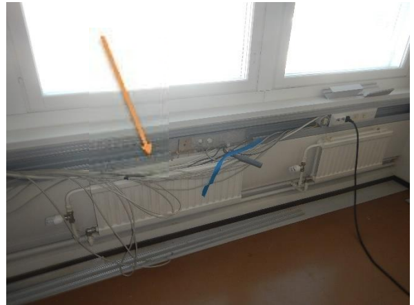
Kuva nro 3. Seinässä kulkee jokaisessa huoneessa sähköjohtokouru.
