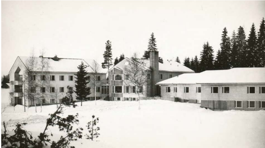
Vanhainkoti vastavalmistuneena vuonna 1954. Kuvasta näkyy alkuperäinen A-talon parvekemuoto, A- ja B-talon välinen terassi sekä C-talon terassi umpikaiteineen. Ulkoportaatt C-talon terassin etupuolelle lisättiin todennäköisesti myöhemmässä vaiheessa. Kuva: Pyhäniemen vanhainkodin rakennushistorian selvitys (Sitowise 2021) / Hollolan kunnan kuva-arkisto.
