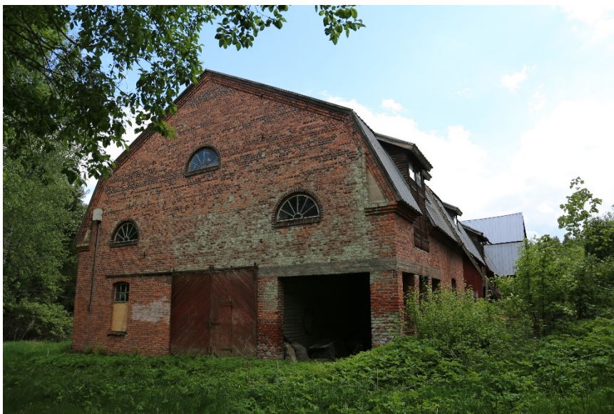
Vanhan puimalarakennuksen pohjoispääty. Kuva: Ramboll 2022.
