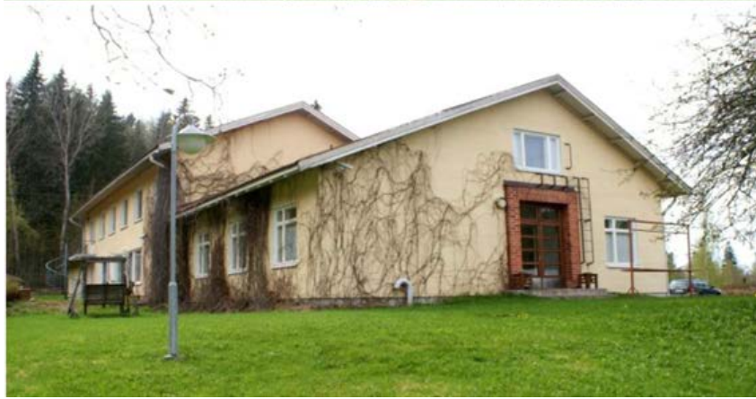
Vanha B-mielisairaala sekä sen pohjoispuolelle (katselusuunnassa eteen) sijoittuva uudempi rakennus näkyvät avoimen peltomaiseman yli Martinraitilta. Kuva: Ramboll 2022.
