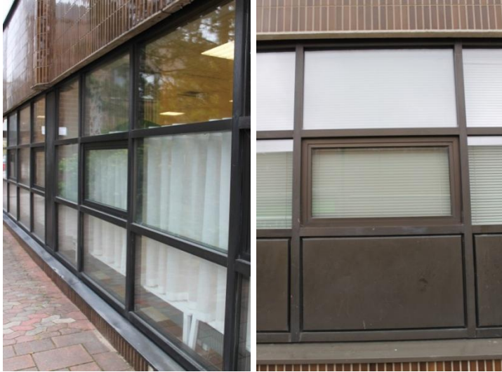
Vasemmalla kokoussiiven B ensimmäisessä kerroksessa sijaitsevan ruokalan ikkunaseinää. Oikealla virasto-osa A:n pohjakerroksen ikkunoita.
