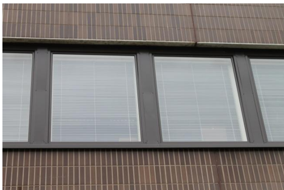
Virasto-osa A:n toimistohuoneiden ikkunoita.
