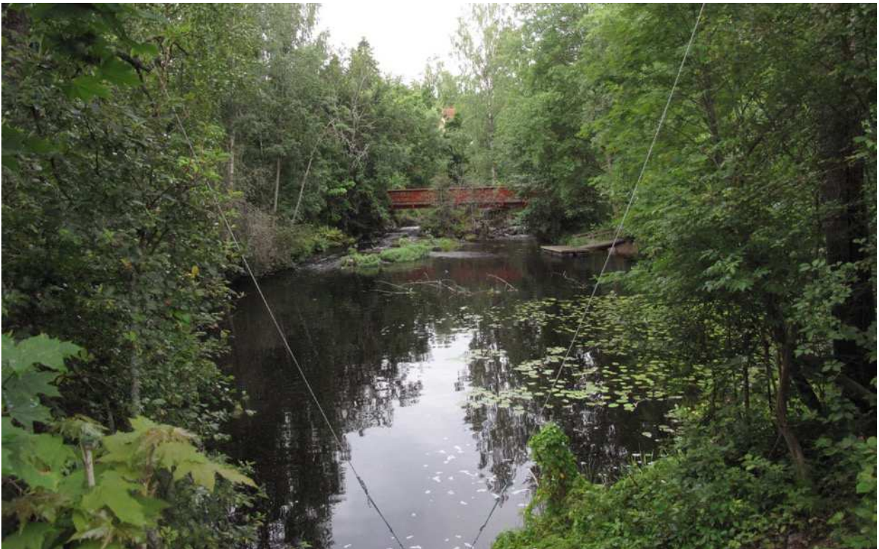
Kuva 21. Teuronjoen ylittävä silta pohjoisesta. Kuva Hannu Takala, Maanala Oy.
