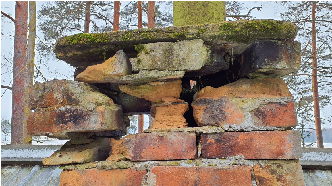
Kuva 9. Rakennus 3, saunan savupiippu.
