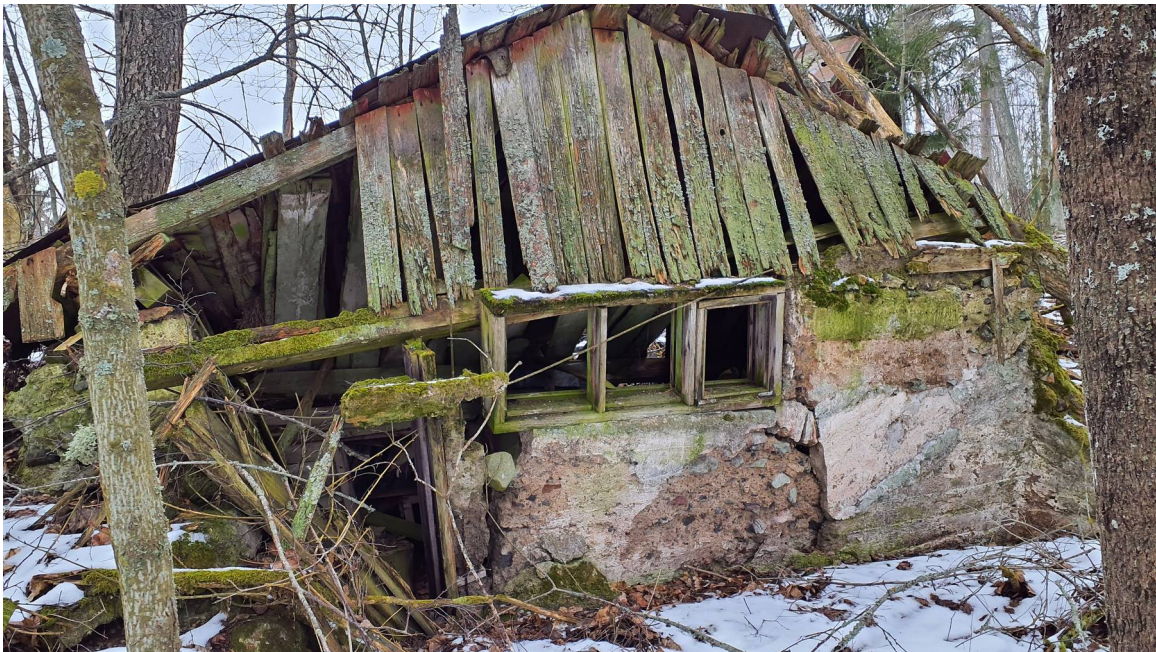
Kuva 11. Rakennus 4, jonka ikkuna-aukkojen pielistä voitiin kerätä näytteitä.
