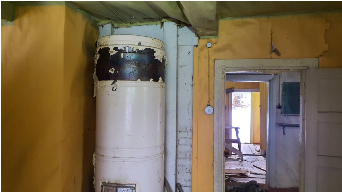
Kuva 2. Rakennuksen 1 tupa, jossa lämmitysuuni.
