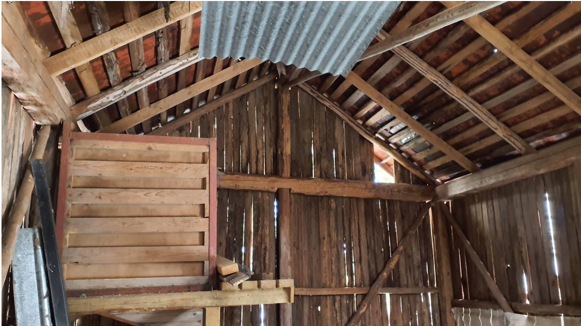
Kuva 6. Piharakennuksen rakenteissa on runsaasti linnuille ja lepakoille soveltuvia kulkureittejä.
