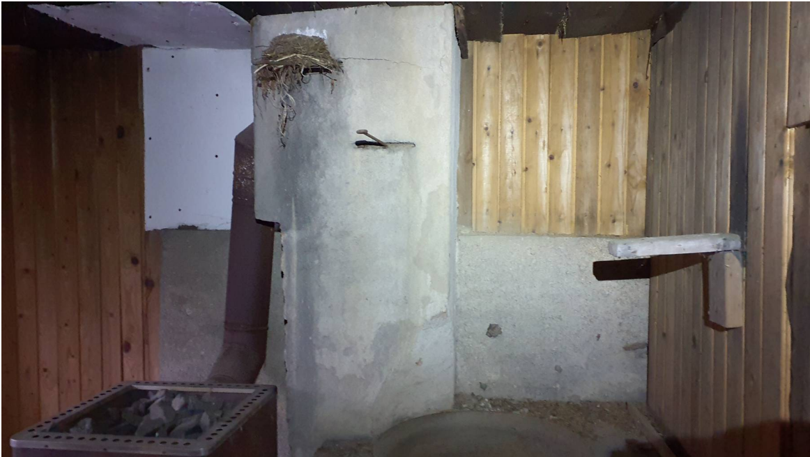
Kuva 8. Rakennus 3, sauna oli avoin tila, josta löytyi linnun pesä ja runsaasti jyrsijöiden ulosteita.
