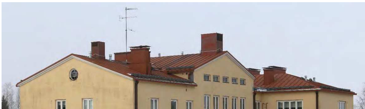
Kuva 64. Koulun kattomuoto on säilynyt alkuperäisenä. Katemateriaali on nykyisin pelti.
