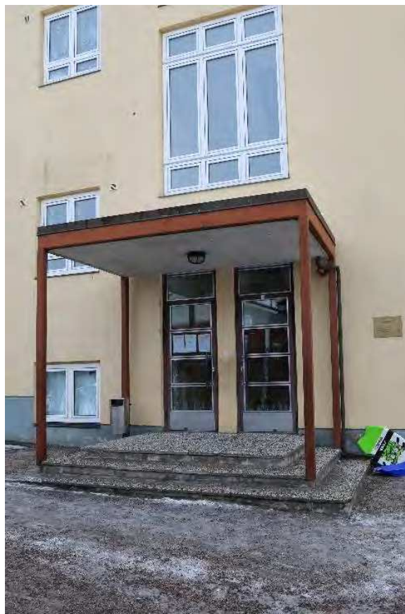
Kuva 70. Pohjoisseinustan sisäänkäynnin yhteyteen on myöhemmin rakennettu katos.
