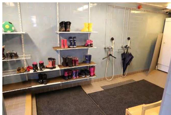
Kuva 106. Kellarikerroksen kurasteinen oli alun perin osa pannuhuonetta.
