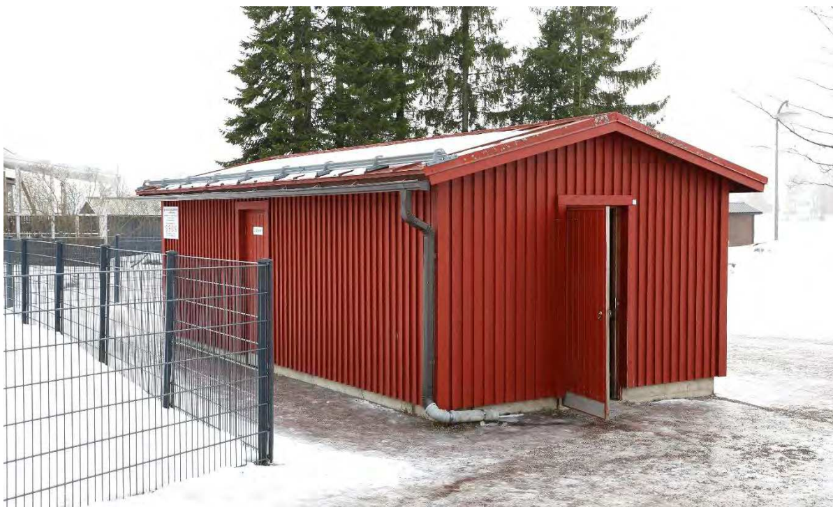
Kuva 131. Jätekatoksen pohjoisosassa on pieni varasto.
