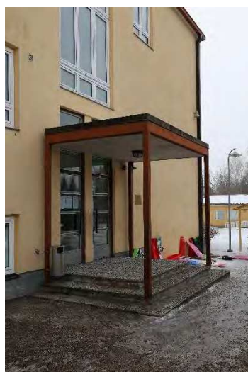
Kuva 38. Pohjoisen sisäänkäynnin yhteyteen rakennettiin katos.
