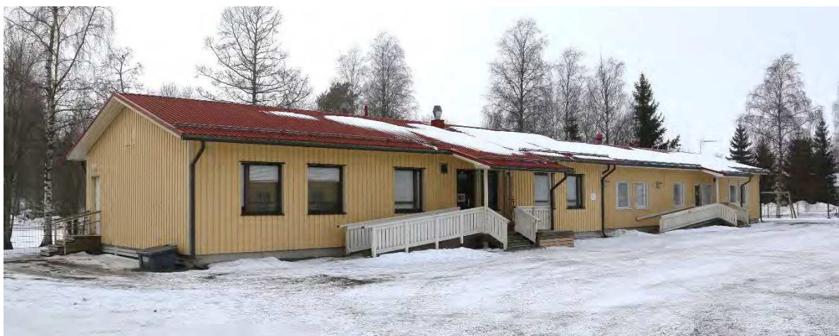
Kuva 113. Puukoulun itäjulkisivu. Vanhassa osassa on ruskeat ikkunapuitteet ja uudessa osassa valkoiset.
