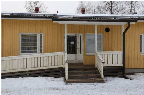
Kuva 116. Uuden osan sisäänkäynti.
