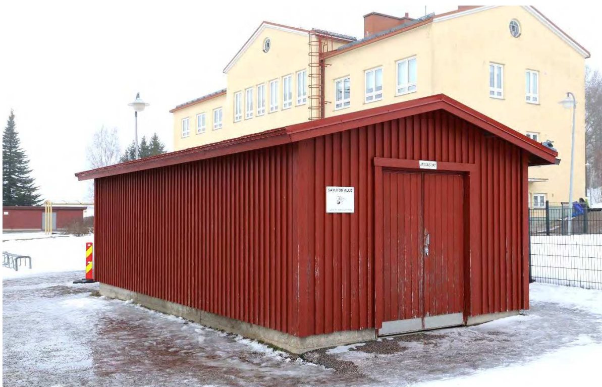
Kuva 132. Eteläosassa on tilat jätteille.
