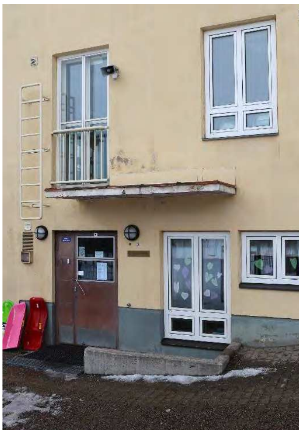
Kuva 69. Eteläseinustan sisäänkäynneistä toinen on muutettu ikkunaksi.
