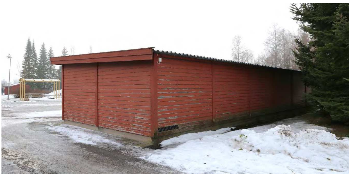
Kuva 130. Rakennuksessa ei ole ikkunoita.
