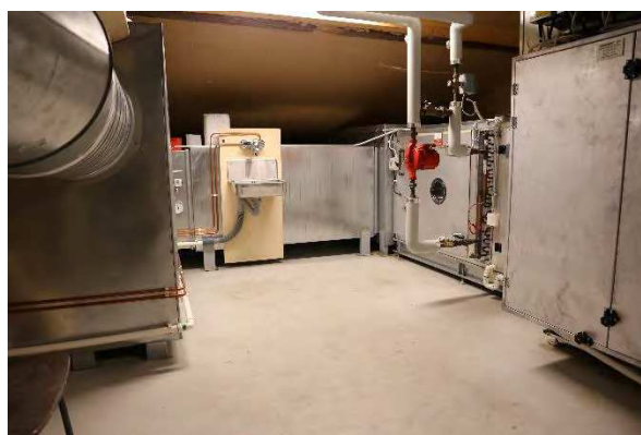
Kuva 112. IV-konehuone rakennettiin vuonna 2001.
