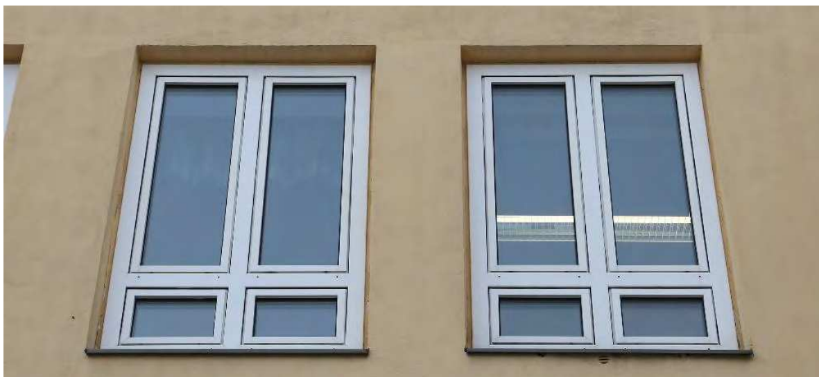
Kuva 65. Koulun ikkunat ovat neliruutuiset ja puitejako on epäsymmetrinen.
