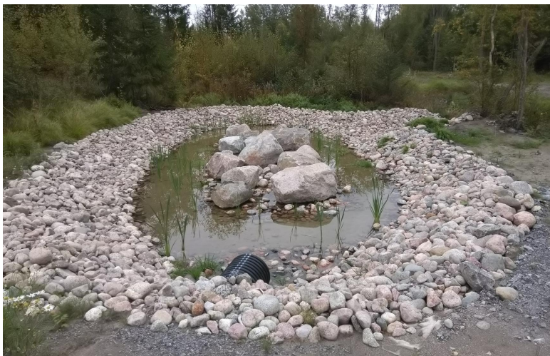
Kuva 18. Esimerkki hulevesipainanteesta hulevesiviemärin purkupisteessä ennen laskuojaa [Ramboll 2021]
