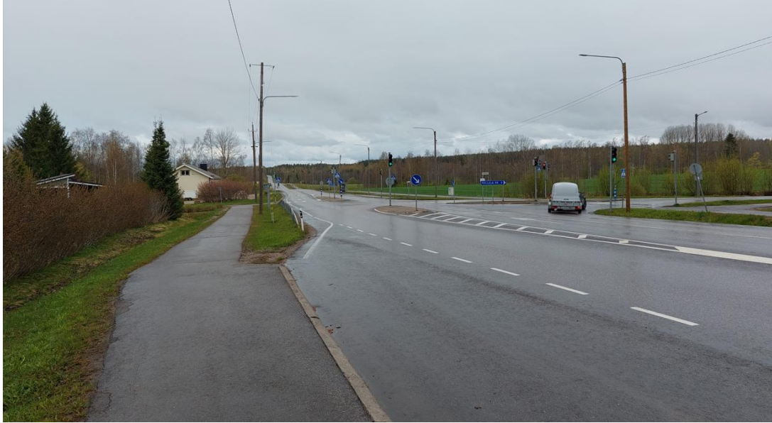
Kuva 4. Yleiskuva suunnittelualueelta, Vanhan Tampereentien, Kirkkotien ja Soramäentien liittymä. [Ramboll 14.5.2025]
