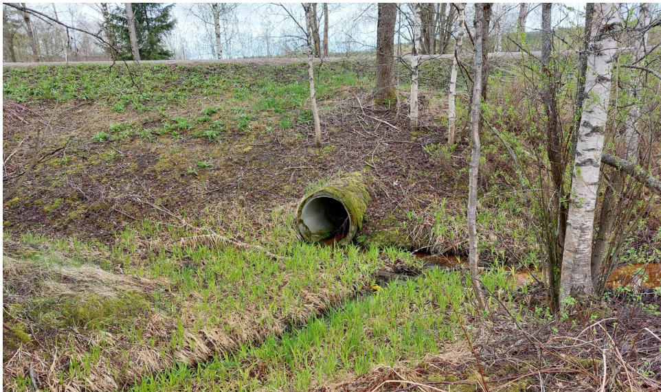
Kuva 12. Jarvalantien alittava nykyinen 800 mm betonirumpu. [Ramboll 14.5.2025]
